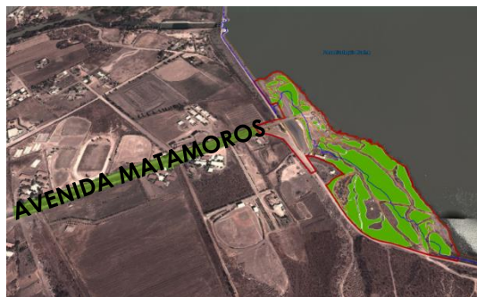
Parque Mirador Presa Eustaquio Buelna
